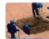
Trabajos de excavaciones superiores a 1.50 m
