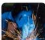
Trabajos en caliente
